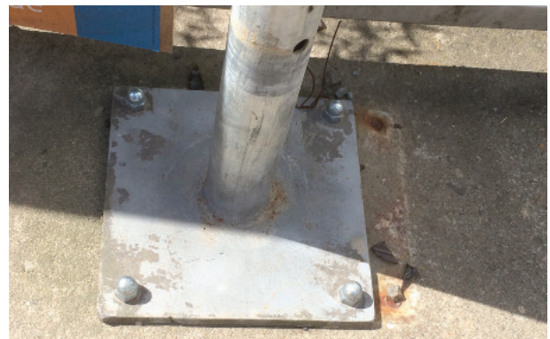
Abb. 6-12: Einbau mit Bodenhülse für befahrbare Flächen
