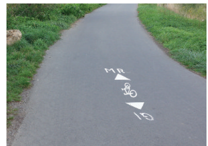
Abb. 4-17: Markierung mit Ortskennung im Flurbereich
