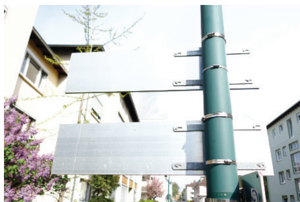
Abb. 6-4: Rückseitige Schildermontage
